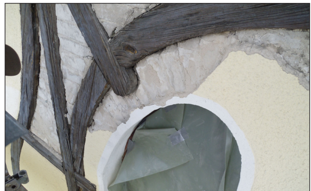
Fachwerk vor Sanierung
