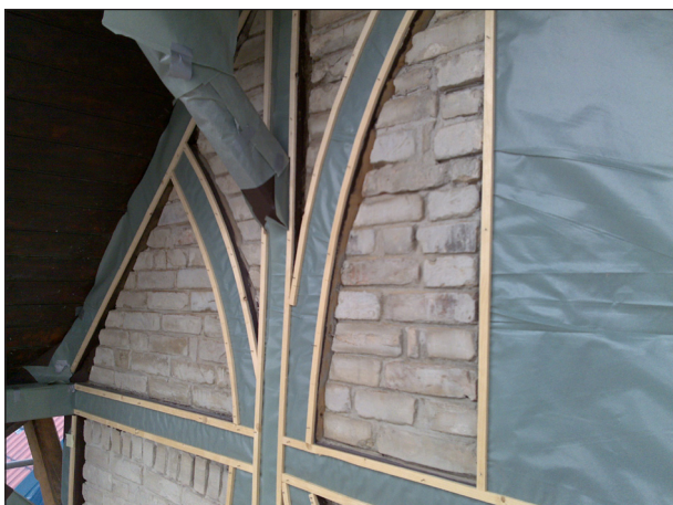
Vorbereitung der neuen Gefache für Putzarbeiten
