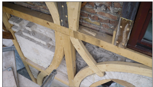
Saniertes Fachwerk
