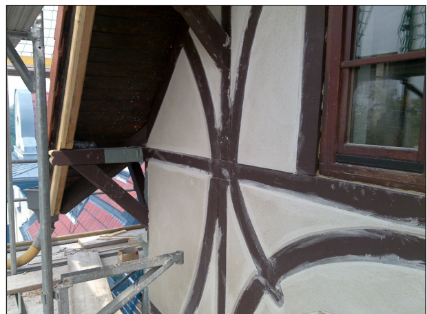
Verputzte Gefache vor Aufbringung der Endbeschichtung
