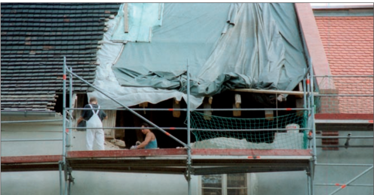
Bereich über Treppenhaus
