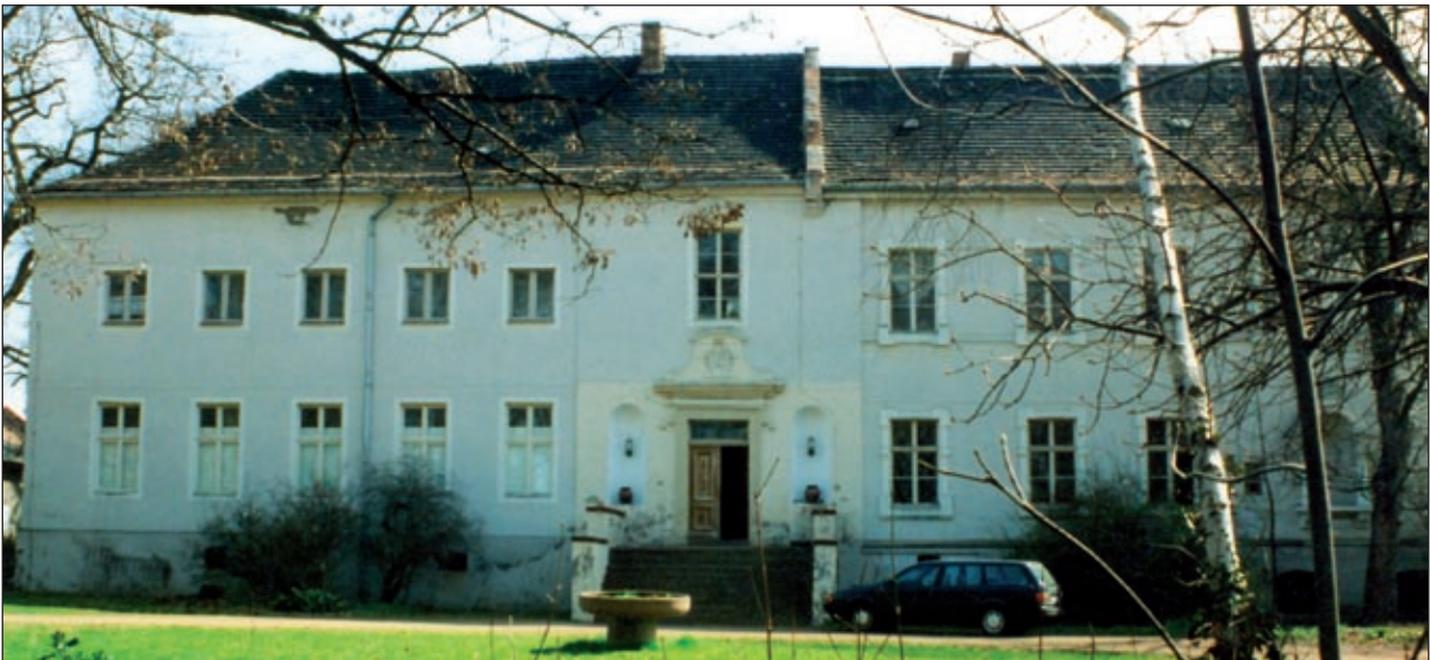
Haupthaus vor der Sanierung
