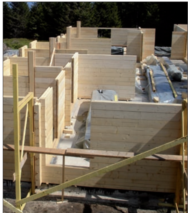
Wand- und Stützenmontage
