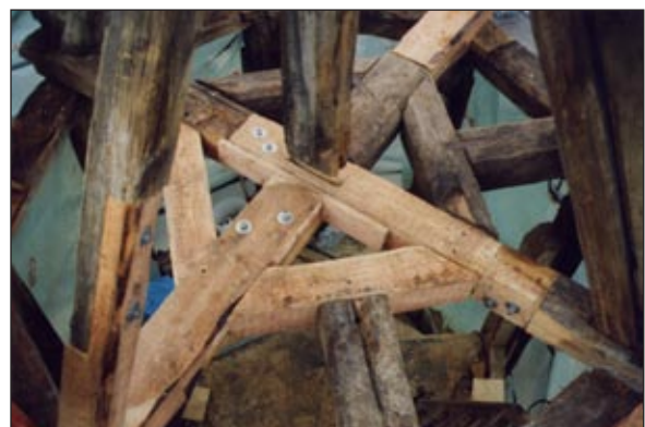
Balkenlage Zwiebelturm – nach der Sanierung
