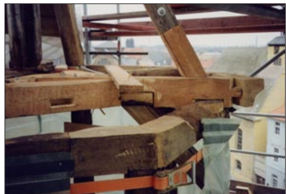
Ringbalken unter Zwiebelturm – nach der Sanierung
