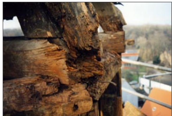
Ringbalken unter Zwiebelturm – vor der Sanierung
