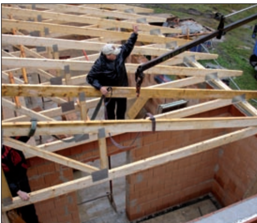
Montage der Nagelplattenbinder auf den Vordächern
