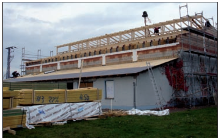
Der fertige Dachstuhl zum Richtfest
