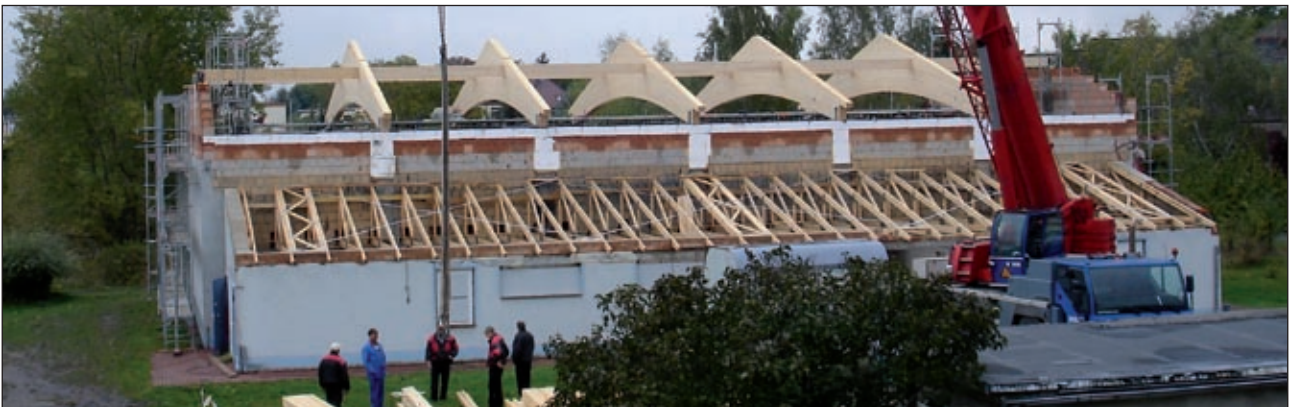
Montage des Hauptdaches
